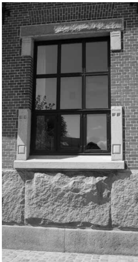
Vindue på sydfacaden, gedigent udført med granithjørner og hvilende på meget store granitblokke. Foto Ole Degn 2009.
