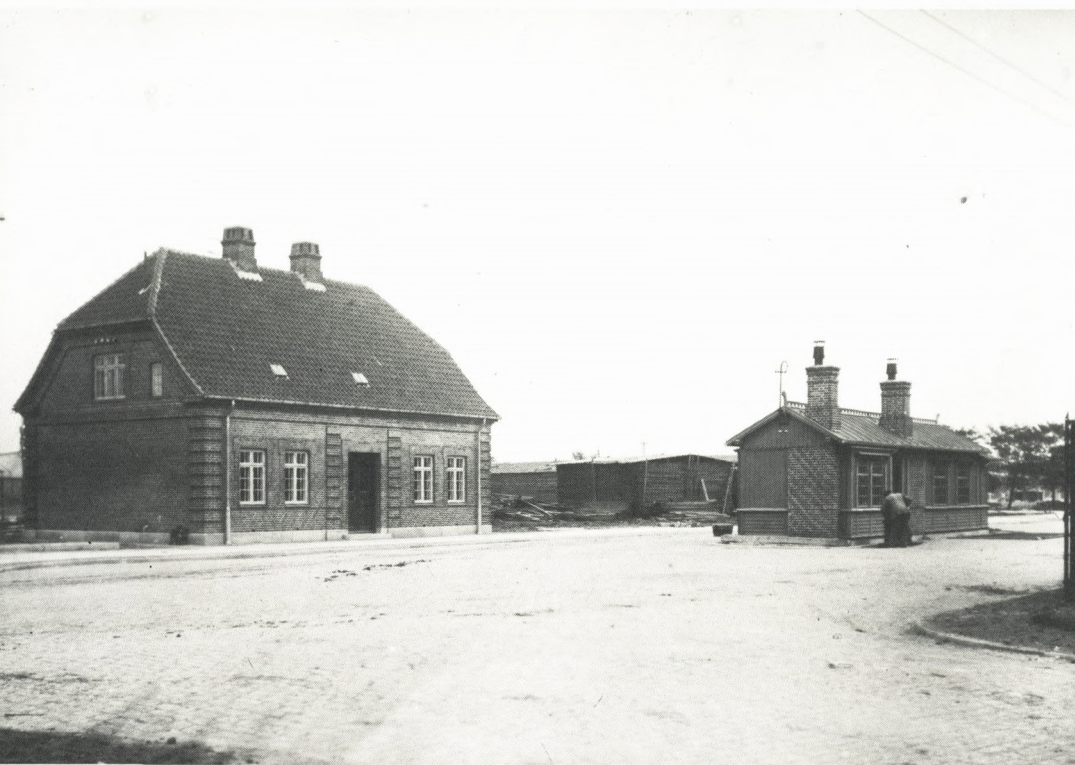
Frihavnen, Århusgade, ca. 1906. Murstensbygningen, der stod uforandret gennem årene, rummede i stuen til højre Frihavnens Toldkassererkontors filial, til venstre kontorer for overopsynet ved Toldvagt 14 (udenfor billedet til venstre) og Brovægt 12, der ses midt i gaden. På 1.sal havde Kalkbrænderiernes Toldforvaltning sine lokaler. (Toldmuseet).
