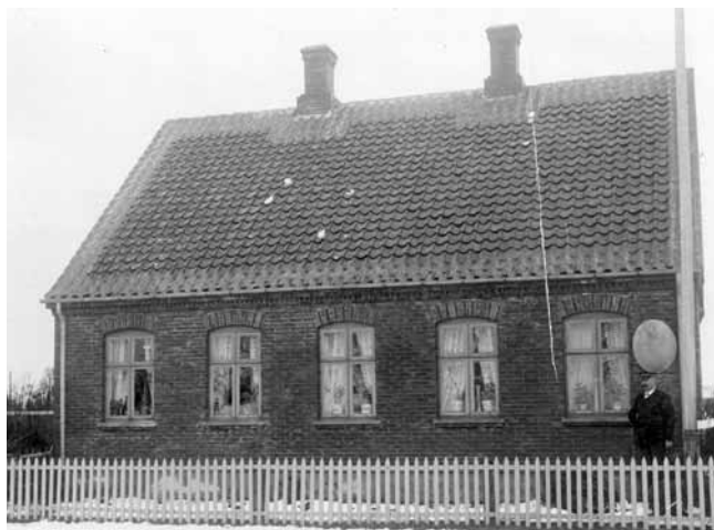
Gottlieb Bindsbøll – i dag nærmest verdensberømt for bl.a. Thorvaldsens Museum og Brumleby – har også ydet dette beskeden bidrag til toldvæsenets bygningshistorie. Det lille uprætentiose længehus ligger ved landevejen, der går gennem Nymindegab. Det daterer sig til tiden omkring 1850. Foto ca. 1900 i Told • Skat Museet.
