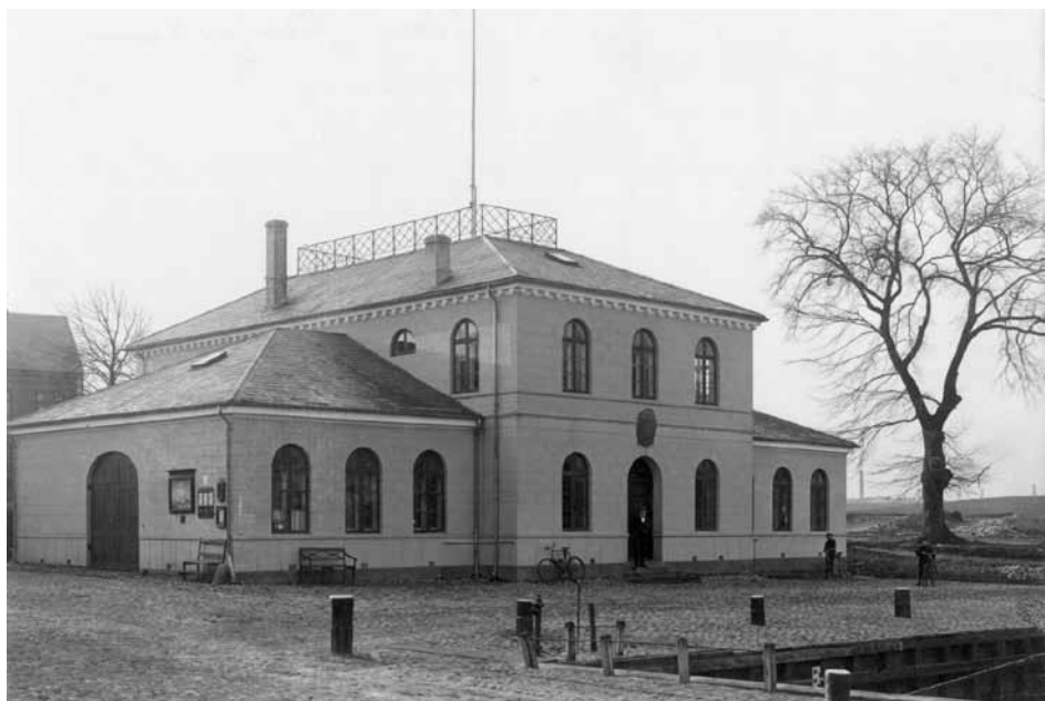
Toldkammeret ved Odense Havn opførtes 1847-48 af arkitekten N.S. Nebelong, der efter J.H. Kochs afsked i 1843 blev en aftoldetaten meget benyttet bygmester. Facadernes kvadermotiv og de rundbuede vinduer fortæller om påvirkning fra Münchenerarkitekten Leo von Klenzes renæssance-inspirerede bygningskunst. Foto Jul. Folkmann ca. 1905 i Told • Skat Museet.
