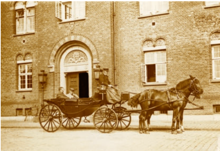
Fig. 7. Toldforvalter E.C.M.B. Vildenskov (f. 1856) til højre i kareten, fotograferet foran Esbjerg Toldkammer 1917. Vildenskov var toldforvalter i Esbjerg fra 8. maj 1908 og frem til sin afsked med virkning fra 1. juni 1926. På fotografiet ses nogle af bygningens fine detaljer. Told- og Skattemuseet, TOP 20130308022.
