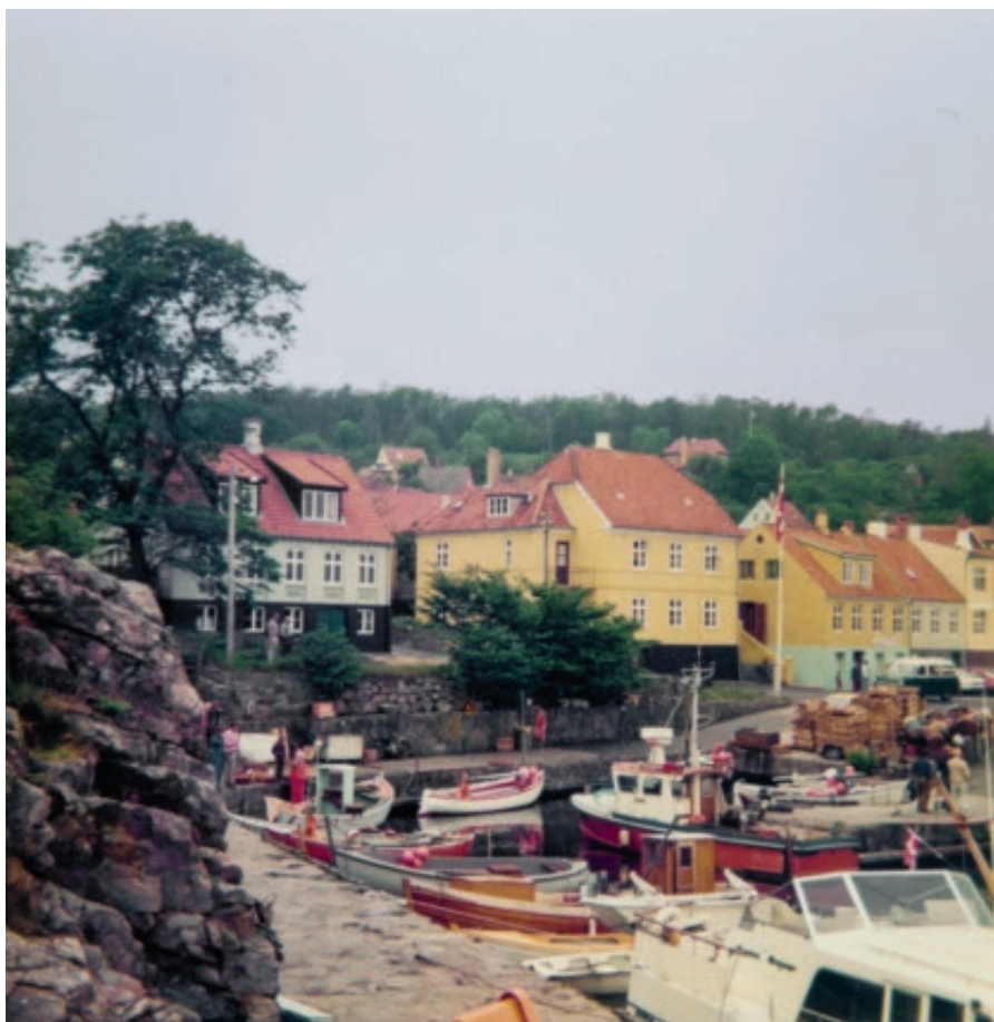
Fig. 6. Ferieboligen i Gudhjem 1974, den gule større bygning. Bygningen fungerede indtil 1944 som selvstændigt toldkammer, hvorefter tjenestestedet fungerede som toldkontrol indtil 1967. I 1970 overtog Den danske Toldetatsforening bygningen og indrettede fire ferie-lejligheder, der kunne lejes af foreningens medlemmer. Foto: Finn Lautrup.
