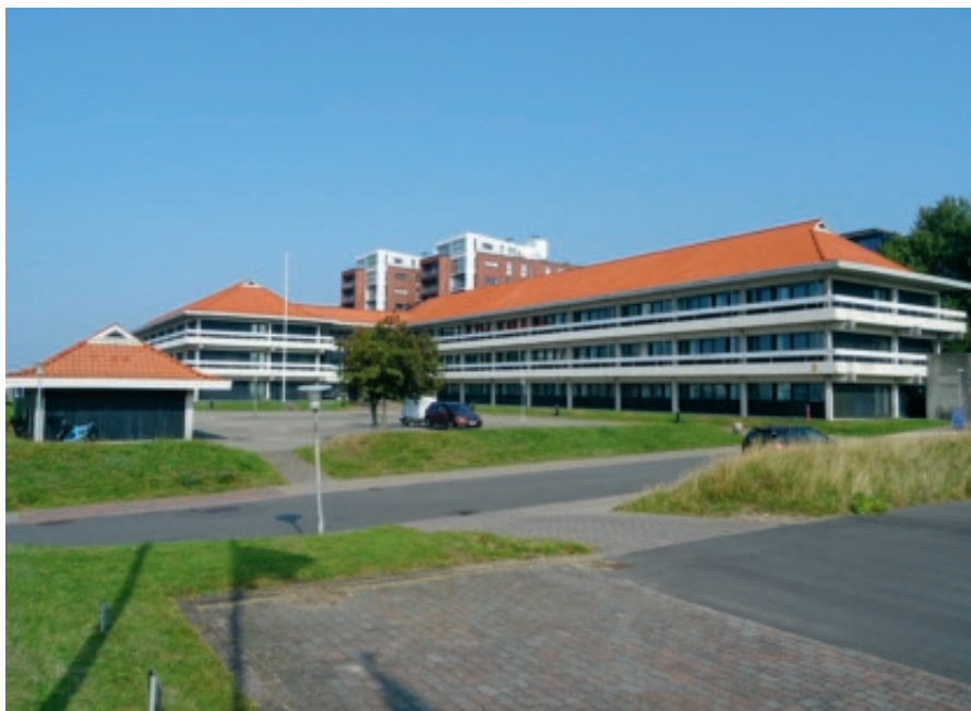
Fig. 15. Den nye distriktstoldkammerbygning i Esbjerg indviet den 6. september 1984. Foto: Bent Hausted Laursen, september 2021.
