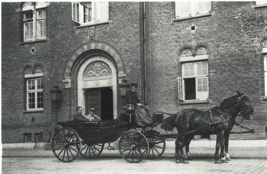
Overtoldinspektør Bunkeflod og toldforvalter Vildenskov klar til afgang i landaueren foran Esbjerg toldkammer en mild oktoberdag i 1917. Dengang var der stil over tolderne, når de kørte på inspektion. Foto i Ole Degns registrant over de norrøjske toldarkiver.
