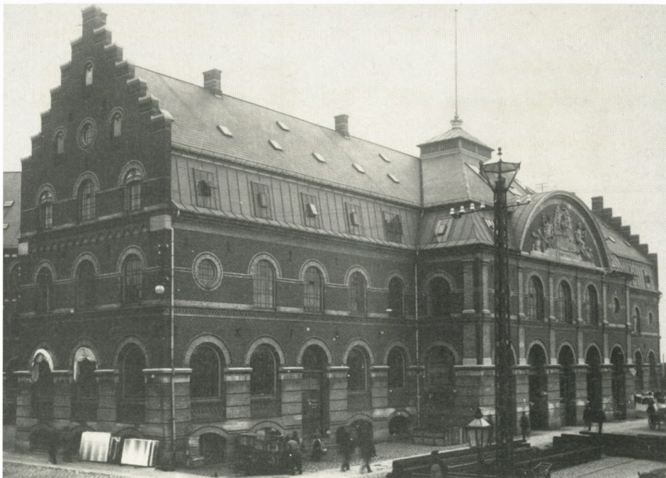
»Toldkammerskiltet« fra 1733 genbrugt på Frilagerbygningen fra 1893.
