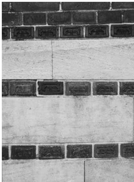
Toldkammerets murværk er mange steder smykket med skifter af kalksten, og mange mursten har indpræget en figur med bogstaverne ATA, Aarhus Toldkammer. Foto Ole Degn 2008.
