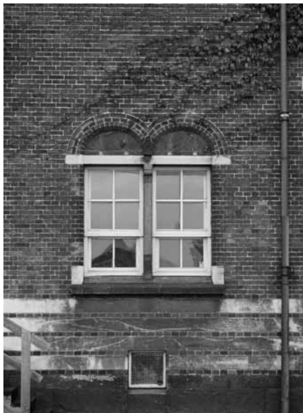
Vinduer på østfacaden. Vinduesformerne er fint varieret. Foto Ole Degn 2008.
