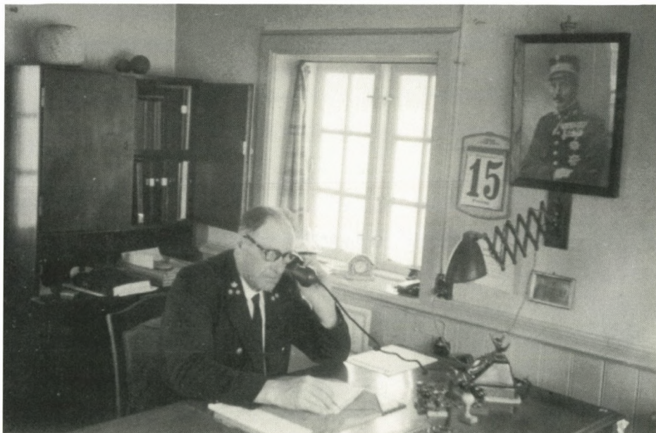
Toldkontrollen ved Rørdal. Året er 1950, den 15. september, men Christian X hænger stadig på sin plads.
