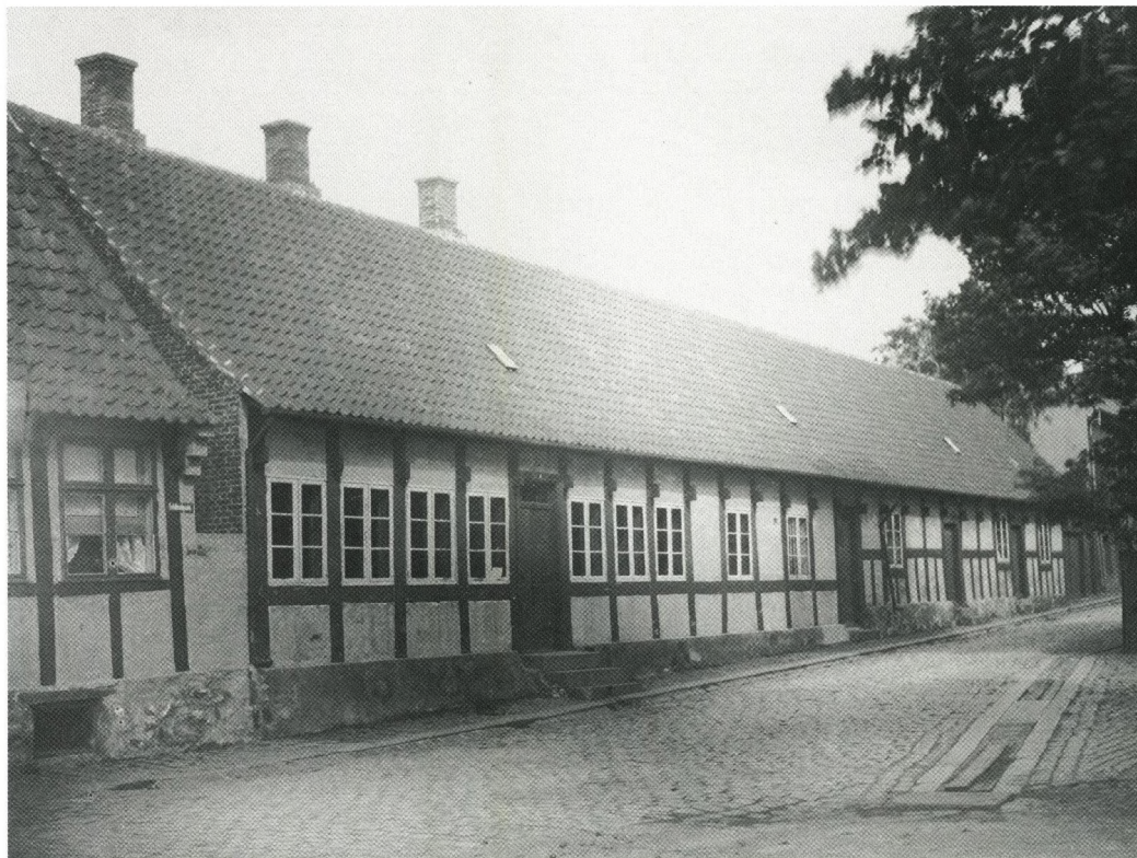
Kornboden på havnen i Rønne, der blev opført i 1684. Her opbevaredes bornholmernes landgilde inden udskibningen til København. Toldboden lå nærmest havnen i Kornbodens vestende bag de fire vinduer. På nabohuset (nu nedrevet) anes gadenavnet Toldbodgade (foto­grafiet tilhører Told- og Skatteregion Bornholm).
