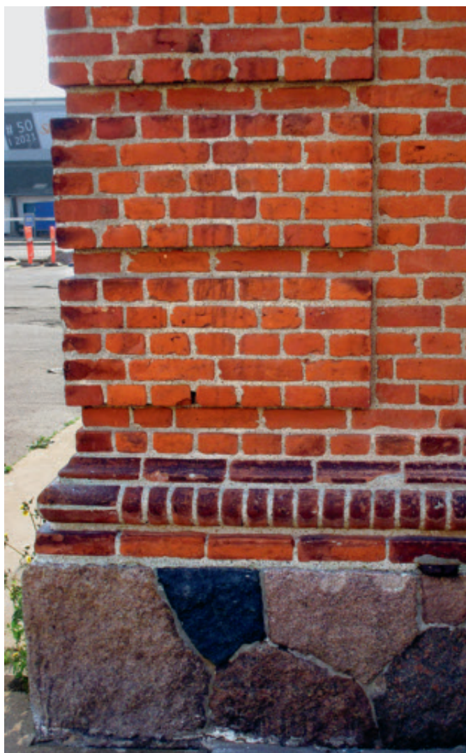
Fig. 16. Kampe- stenssokkel, profi- leret sokkelgesims og murede lisener. Suverænt hånd- værk. Foto: Hans Nielsen.
