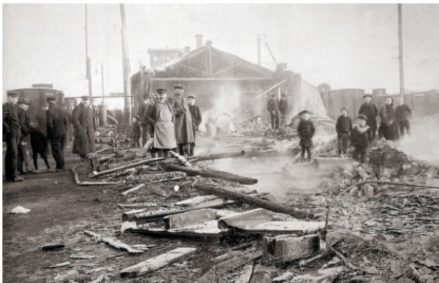
Fig. 13. Vamdrup Station efter branden i 1911. Den 7. februar 1911 udbød der brand i den sydlige del af stationsbygningen. Branden opstod i lampisteriet, det lokale, hvor der blev hældt petroleum på togenes lamper. Det var under en sådan påfyldning, at branden brød ud. Det lykkedes dog at stoppe branden, inden den nåede toldvæsenets lokaler, men alligevel blev en del af toldvæsenets inventar flammernes bytte, mens andet blev vandskadet. Det ser ud til, at tegningerne til stationsbygningen fra 1866 til en vis grad blev genanvendt ved genopførelsen. Den nye bygning blev nedrevet i forbindelse med opførelsen af en ny station i 1955. Fotografi fra 1911, ukendt fotograf. Lokalhistorisk Arkiv for Vamdrup.
