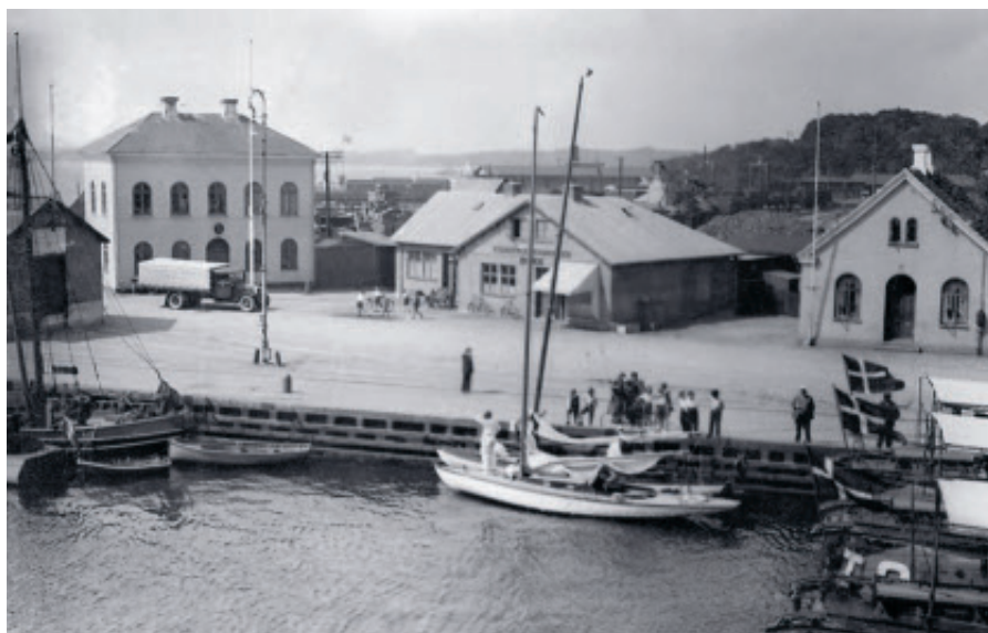
Fig. 4. Gl. Havn i Fredericia omkring 1930, hvor byens toldkammer nummer to og tre begge ses. Bygningen til højre er toldkammeret fra 1810'erne, mens bygningen til venstre er toldkammeret fra 1845. Efter opførelsen af det tredje toldkammer blev forgængeren ombygget til havnefogedbolig. Denne funktion havde den til 1913. Foto: Lokalthistorisk Arkiv, Museerne i Fredericia.
