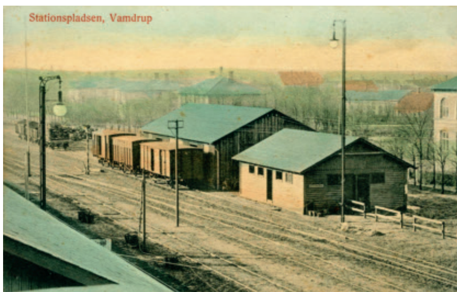
Fig. 27. Stationspladsen set fra kommandoposten. I forgrunden skinnelegemet, toldpakhus med vejerbod samt depotbygning, og i baggrunden skimtes embedsboligerne for ansatte ved toldvæsenet og jernbanen. Således ses længst til venstre i billedet toldforvalterens bolig, den næste bygning var frem til 1899 stationsforstanderens bolig, mens den tredje bygning husede jernbane- og postpersonale på gennemrejse og helt til højre ses »den nye« stationsforstanderbolig fra 1899, der siden 1985 har huset Kongeåmuseet. Håndkoloreret postkort fra omkring 1908, P. Hansen, Vamdrup. Bjarne Hansens postkortsamling.
