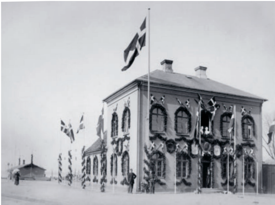
Fig. 6. Toldkammerets tilknytning til kongehuset var synligt til dagligt over døren på et skilt, men ved særlige lejligheder blev tilknytningen endnu mere synlig. Således blev toldkammeret udsmykket, som det ses på billedet, i forbindelse med kong Christian IX og dronning Louises guldbryllup den 29. maj 1892. Og naturligvis førte det kongelige toldkammer splitflag. Foto: Lokalthistorisk Arkiv, Museerne i Fredericia.
