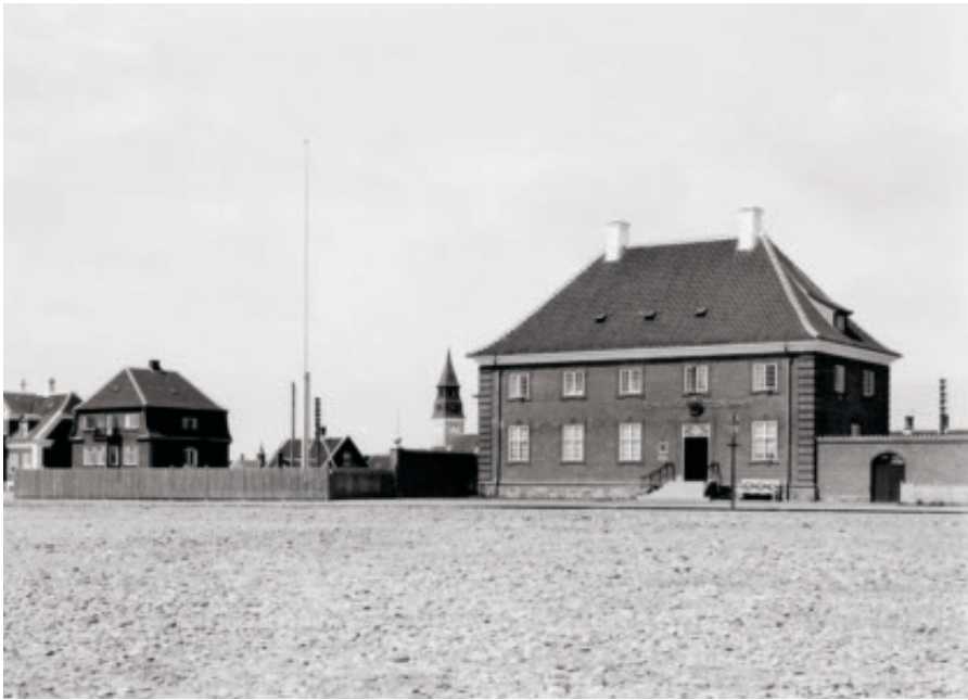
Fig. 11. Toldkammeret lå markant på havnefronten i 1912 med Ulrik Plesners bolig for kontor Larsen som nærmeste nabo. Den parklignende have mod vest var indhegnet af et rødmalet stakit. Den murede gård mod øst rummede vaskerum, brændselsdepoter, pissoir og tre lokummer. Foto: Nordjyllands Kystmuseum, Lokalhistorisk Arkiv Skagen.
