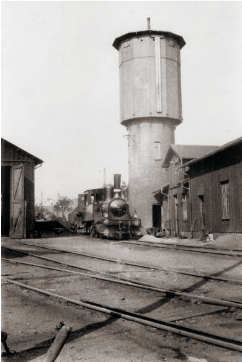
Fig. 12. Efterhånden som trafikken tog til opførtes forskellige bygninger på jernbaneterrænet. På det vestre terræn, det danske område, opførtes lokomotivremise, kulhus, vandtårn, vandkran, drejeskive, og varehus med vejerbod til omladning af gods og kvægrampe. Her ses vandtårnet efter at det var blevet forhøjet i 1914. Toget, der ses, er et af de driftssikre rangerlokomotiver af typen Litra F. Fotografi fra ca. 1916, ukendt fotograf. Lokalhistorisk Arkiv for Vamdrup.
