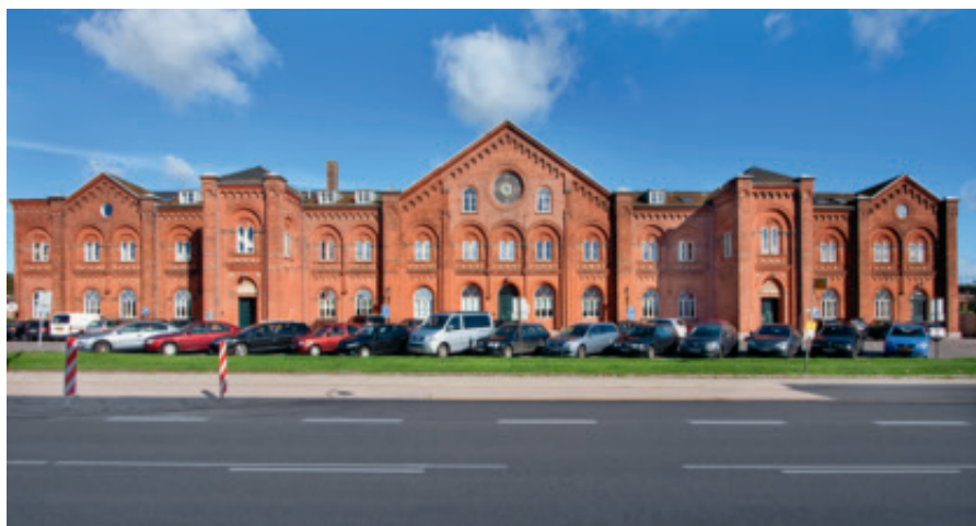
Fig. 7. Den gamle banegård fra 1869 i Fredericia var tegnet af arkitekt N.P.C. Holsøe. Holsøe var en af de mest brugte banegårdsarkitekter i sin tid, og opførte bl.a. de fleste stationsbygninger på de jysk-fynske baneanlæg. Holsøe udviklede den typiske købstadsstation med pavilloner og en trekantet gavl med ur, som også ses i Fredericia. Bygningen benyttes nu til private virksomhedskontorer. Foto: Lokalthistorisk Arkiv, Museerne i Fredericia.
