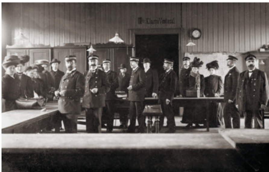
Fig. 15. Tolderne står klar i »Toldsalen« til at modtage de rejsende for at tjekke tasker og kufferter. Alle passagererne skulle i Vamdrup gennem tolden ved indrejse fra Tyskland eller udrejse sydpå, skønt den egentlige grænse lå omkring fem km længere sydpå ved Farris. Fotografi fra ca. 1906. Told- og Skattemuseet.
