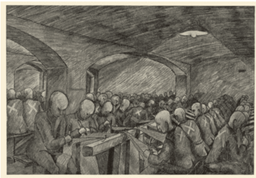
Fig. 17. Under et Par Blokke, som var opført af Sten, var der store Kældere, som benyttes til Ophold for samtlige Fanger i Lejren under Luftalarm, og tillige brugtes af mange Hundrede syge og udtærede, hvis sidste Kræfter udnyttedes til Knytning af Camouflagenet o.lign.
