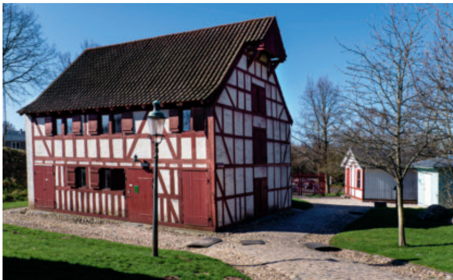
Fig. 1. Bertel Bruuns pakhus kendes nu som Brøchners Pakhus. Det blev oprindeligt opført i 1797, men er to gange blevet nedrevet og genopbygget et nyt sted. I 1832 blev det flyttet fra stranden til havnen i Fredericia, og i 1982 blev det flyttet til Fredericia Bymuseum, hvor pakhuset fortsat bliver brugt af museet. Foto: Lokalthistorisk Arkiv, Museerne i Fredericia.
