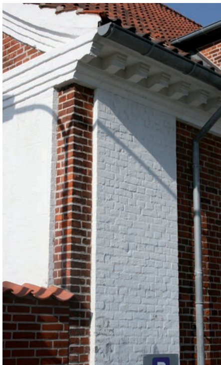
Toldkammerbygningen sydvesthjørne, fint udformet med hvidpudsede lisener, gesimer og en række konsoller under taggesimsen. Foto Ole Degn 2011.
