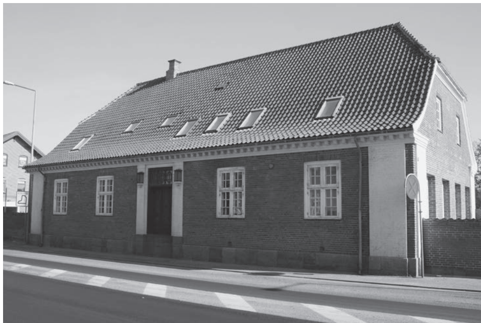
Hjørring toldkammer set fra nord 2011. Facaden er skæmmet af, at granittrappepartier er fjernet. Foto Ole Degn 2011.
