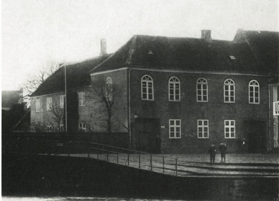
Ribe Toldkammer indtil 1969. Det nu stående forhus med sidebygning, der udgør ejendommen Overdammen 12, er opført i 1831. I 1761 omfattede toldbodgården et 20 fag dybt bindingsværks-gavlhus i to etager og et grundmuret 5 fags hus i én etage langs Overdammen, det sidste formentlig opført i 1604. Foto i Toldmuseet.
