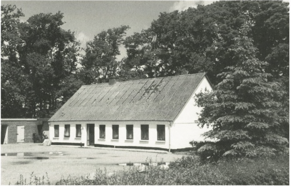
»Toldstedgården« ved Bastrup.
