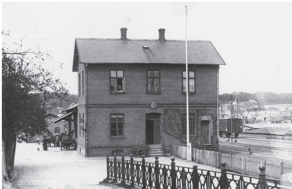
Toldkammeret ved jernbanen er den to etagers del bygningen..
