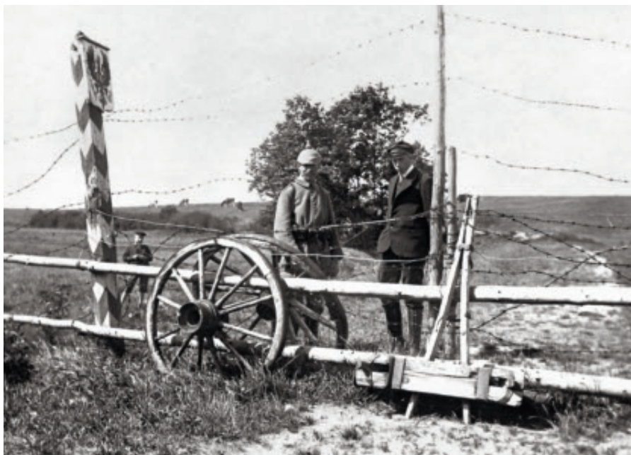
Fig. 32. Grænsespærringen ved Holt under Første Verdenskrig, set mod syd. Landevejen var før krigsudbruddet en pænt trafikeret vej mellem Skodborg og Jels. Det fremgår tydeligt, at vejspærringen har eksisteret et stykke tid, da grusvejen er ved at springe i blomst. Midt i billedet er det formentlig gårdejer Ferdinands søn fra Vandmøllegården og en tysk militær vagt med pikkelhue, som får sig en sludder under afslappede former. Fotografi ca. 1916. Fotograf G. Rentzmann. Lokalhistorisk Arkiv for Vamdrup, B756.
