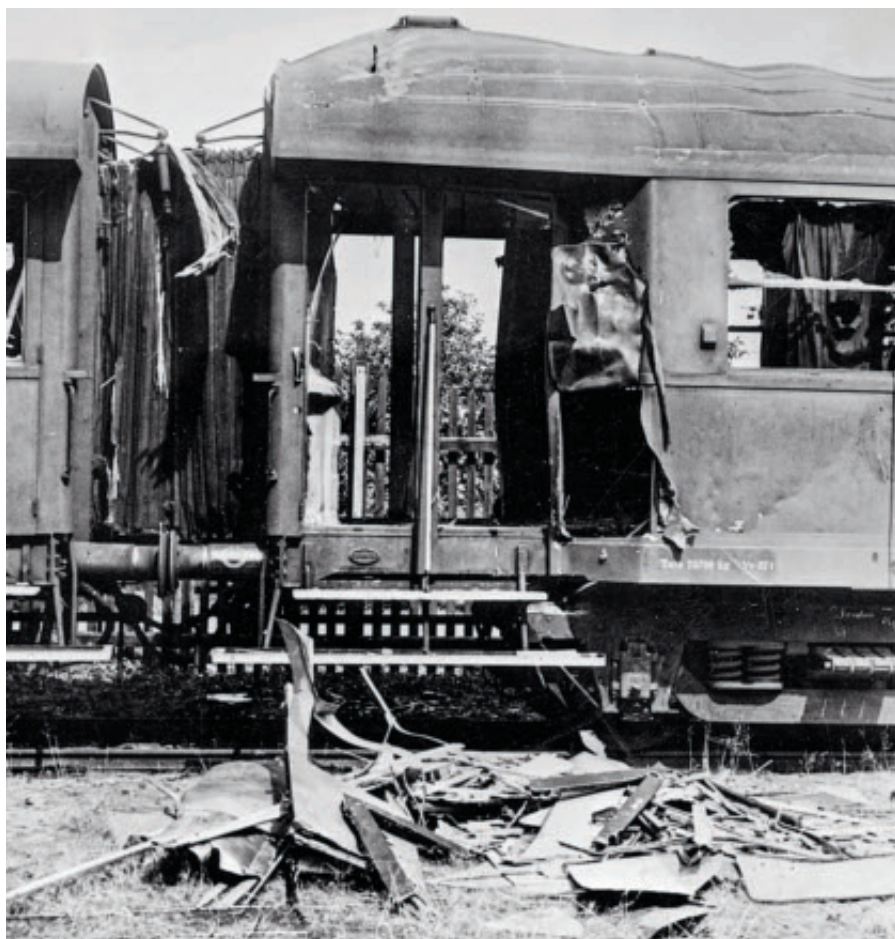
Fig. 1. Togattentat ved Lillerød Station den 27. juli 1944. Den sprængte storrumsvogns ydre. Foto: Frihedsmuseets fotoarkiv.
