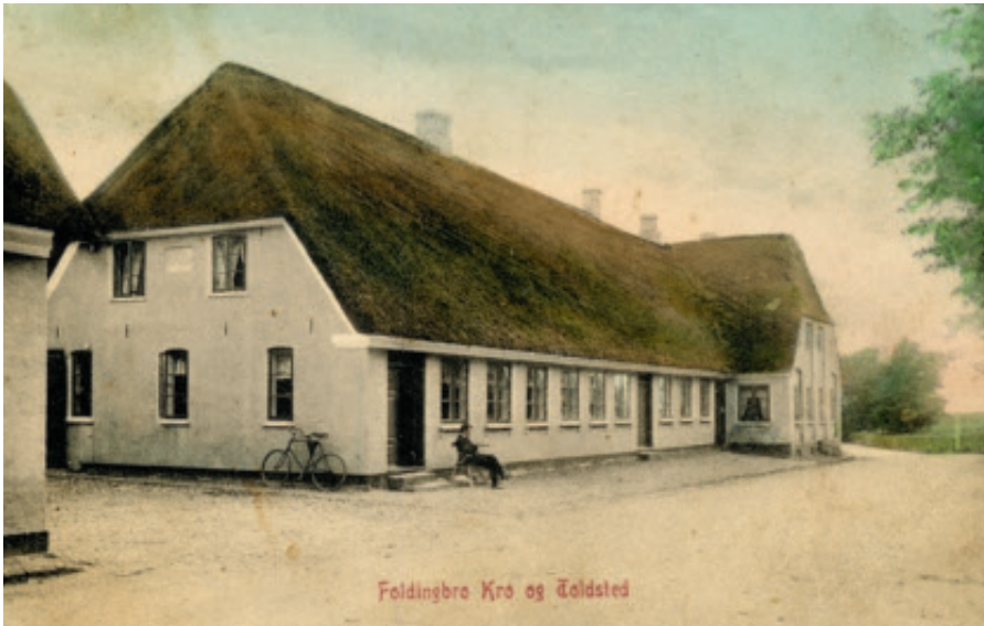
Fig. 4. Foldingsbro Kro og Toldsted, set mod vest omkring århundredskiftet. Kroen var opført i 1790 og nedbrændte den 27. april 1906. Kroen blev i folkemunde kaldt Den gamle Toldergård, da kroen havde huset toldstedet på grænsen mellem kongeriget og hertugdømmerne. Før toldgrænsen rykkedes ned til Ejderen 1. januar 1851, nedlagdes toldstedet, og bygningerne solgtes på auktion. Postkort fra ca. 1905. Ukendt fotograf. Historisk Arkiv for Brørup og Omegn, B2929.
