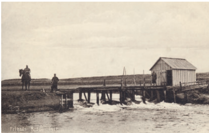
Fig. 14. Friheds Broen 1917. Straks efter Første Verdenskrigs udbrud i august 1914 brød preusserne Frihedsbroen op på deres side af åen. Dette forhindrede dog ikke, at mange krigsfanger siden flygtede til Danmark netop denne vej, da de undvegne soldater kunne skimte lyset i Friheds oplyste stuer. Til venstre i billedet observeres en dansk bereden sergent og en gendarm. På den tyske side ser det ud til, at der er opsat en ny vagthytte, så de tyske gendarmere kunne finde læ, når vind og vejr bød det. Postkort fra ca. 1917. Fotograf S. Sørensen, Vamdrup. Jens Bruhns samling.
