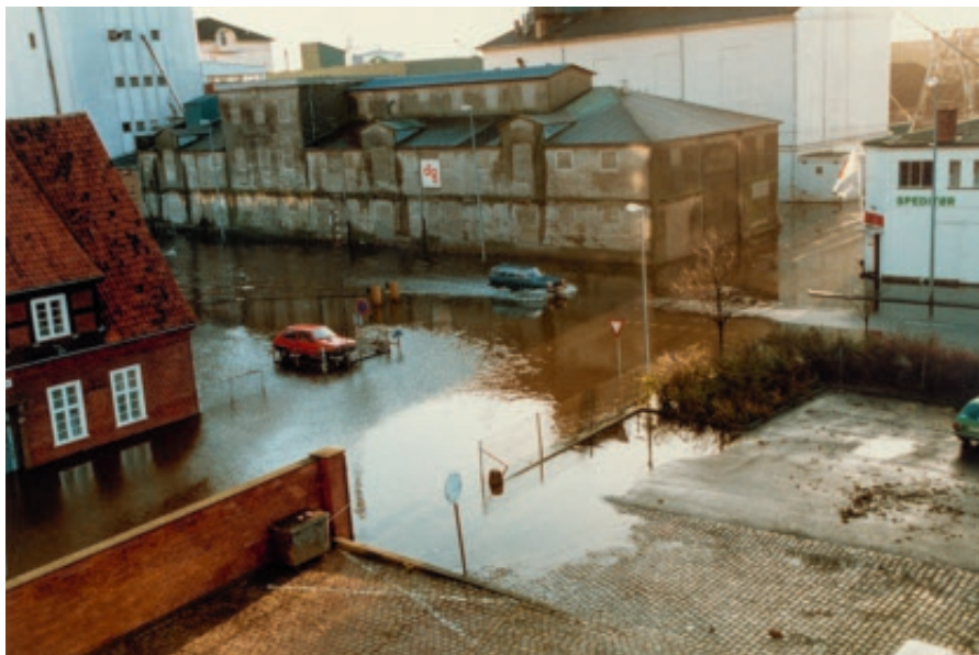
Fig. 3. Billedet er taget fra et vindue i distriktstoldkammerbygningen. Bemærk vandlinjen på dl-g-bygningen. Vandet har stået ca. 1 m højere end på billedet. Foto i privateje.
