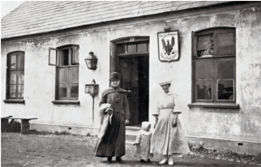
Fig. 52. To kvinder har taget opstilling foran det tyske toldsted ved Bastrup-Jels Troldkær, hvor den yngre er Emma Rentzmann, gift med fotograf Gerhard Rentzmann, mens den lille pige er datteren Edith, der er født i 1918. Den ældre kvinde er måske bedstemoderen. På bygningen, der ser ud til at trænge til at blive kalket, ses toldskiltet med påskriften Königl[iches] Preuss-[isches] Neben-Zoll-Amt II. Fotografi fra 1920. Fotografen er formentlig Gerhard Rentzmann, Vamdrup. Lokalhistorisk Arkiv for Vamdrup, B1087.
