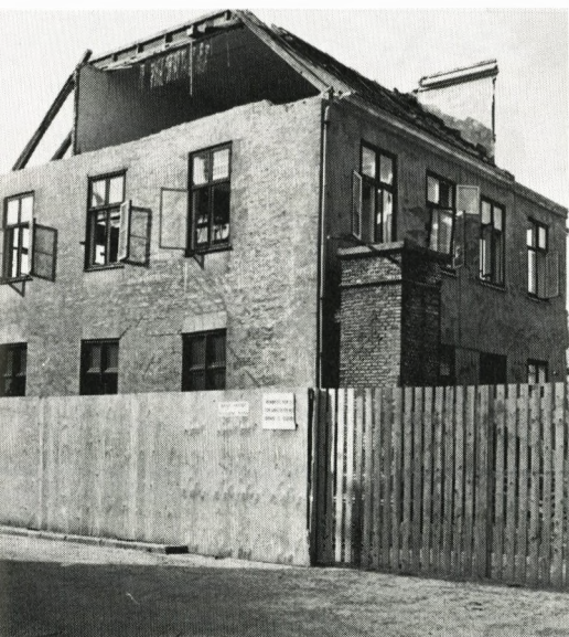
Guidekasernen under nedrivning.
