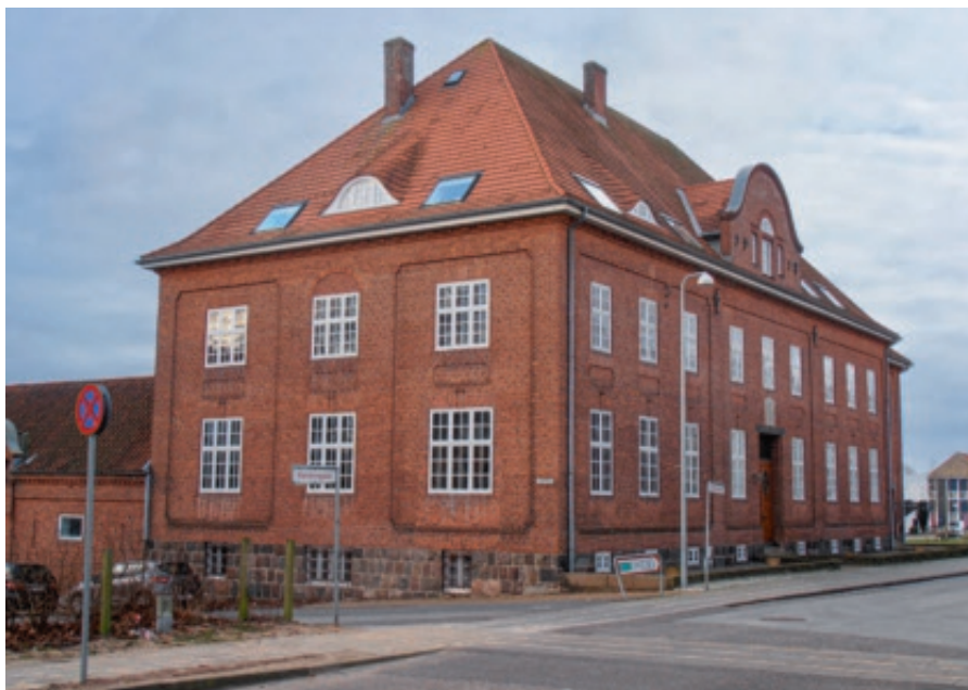
Fig. 3. Toldboden på Skibbrogade er tegnet af den preussiske kredsbygningsinspektør F.W.A. Jablonowski i tidens moderne arkitekturform, slesvigsk hjemstavnstil. Bygningen blev indviet i 1912. Foto: Helge C. Jacobsen, 2020.
