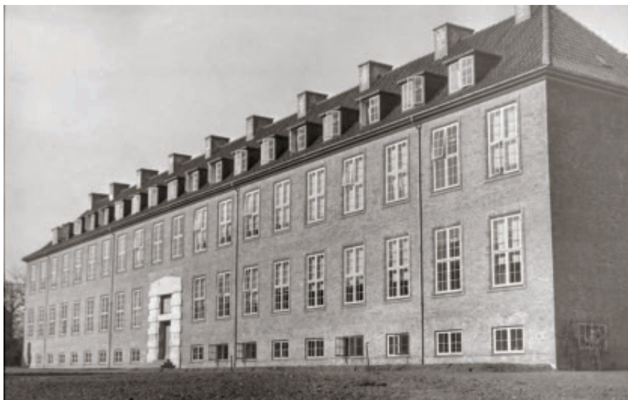
Fig. 5. Haderslev Amtssygehus, der efter nedlæggelsen i årene 1979-2003 kom til at rumme Haderslev Distriktstoldkammer/Told- og Skatteregion Haderslev. Den fine bygning er tegnet af arkitekt V. Norn fra Horsens. Fotografiet er taget omkring 1935. Foto: Horsens Byarkiv.
