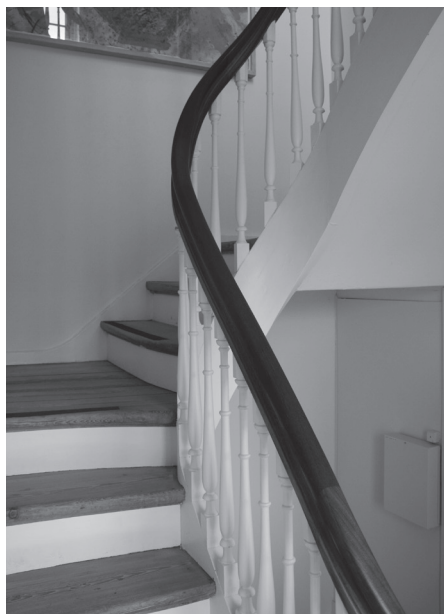
Del af trappen op til loftsetagen i Ebeltoft Toldkammers og Amtstues bygning indrettet som glasmuseum. Gelænderet er båret af fint udformede balustre. Trappen ses på planen til venstre for forstuen. Foto Ole Degn 2013.
