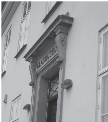
Døroverligger båret af volutkonsoller i indgangspartiet af sandsten i Ebeltoft Toldkammers og Amtstues bygning indrettet som glasmuseum. Foto Ole Degn 2013.
