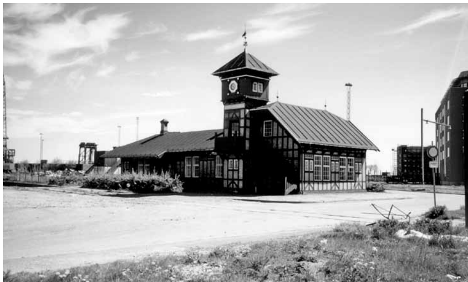
Bygningen ved det gamle Malmöfærgeleje ved Dampfærgevej set fra sydvest. Foto 1996 i privateje.
