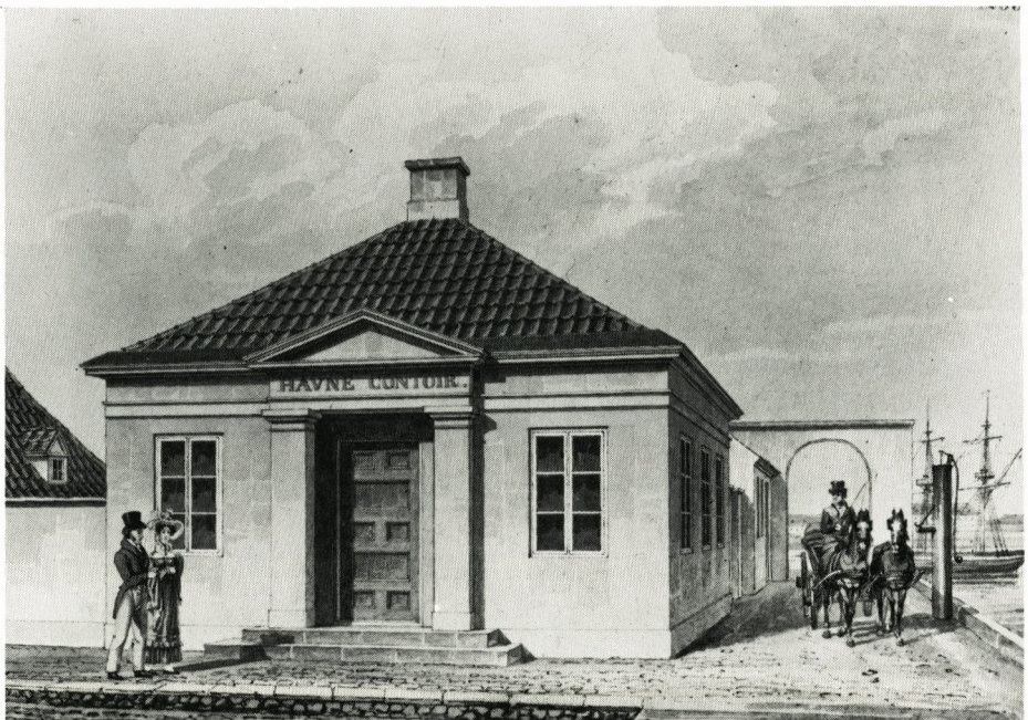
Havnekontoret ved Kvæsthuset (tusch/vandfarve 205 × 284 Nationalmuseet 2. afd). Bygningen blev opført ca 1828 som erstatning for et ældre skur på pladsen overfor det gamle Kvæsthus i Kvæsthusgade, dvs. D.F.D.S.'s nuværende hovedkontor. Den blev nedbrudt i 1855.
