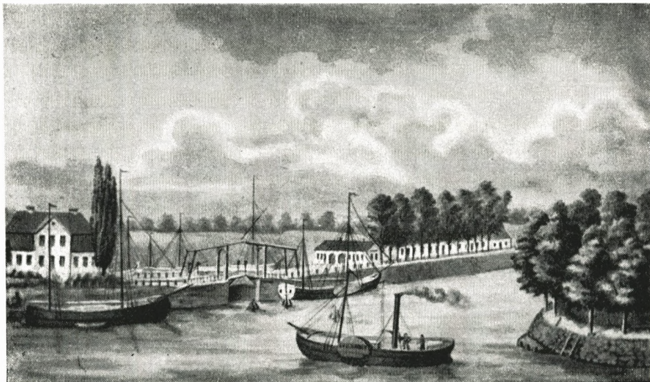
»Die Eider« ved sluse i Rendsborg. Illustration i »Die Geschichte der Firma Zerssen & Co 1839 - 1939«.
