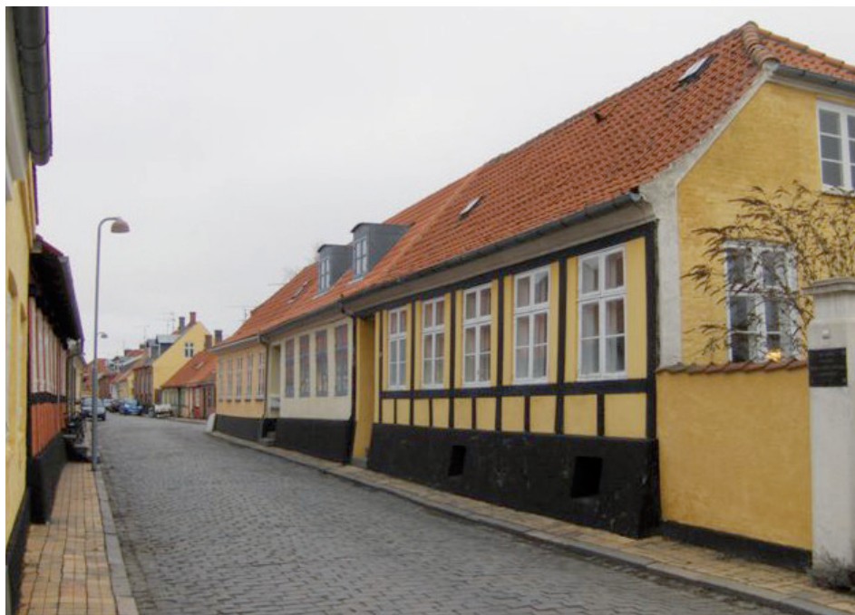
Grønnegade 28 og 30 samt Silkegade 10 i Rønne, set fra syd. Ejendommene har tilsammen 16 fag mod Grønnegade og udgjorde den vestlige længe af ”Ridder Wolffsens Gård”. Foto: Mogens Lau 2011.
