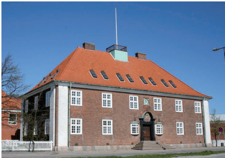
Frederikshavn Toldkammer set fra sydøst, fra Havnegade. Til venstre ses den sydligste af de to nye sidefløje. Foto Ole Degn 2011.
