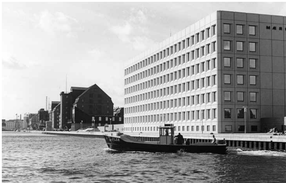
Fig. 4. Rederiet A.P. Møllers nye hovedkvarter set fra Københavns Havn. Fotografiet stammer fra 1979, hvor den seks etager høje fløj nærmest Nordre Toldbod stod færdig, mens fundamentet til den fire etager høje fløj, der var trukket tilbage på linie med den nyopførte bygnings vestfacade, skimtes i baggrunden. Bag fundamentet ses Direktoratet for Toldvæsenets karakteristiske bygning. Bag denne bygning ses Vestindisk Pakhus, dernæst Gule Pakhus og bagerst Blå Pakhus. På selve havnepromenaden anes Søren Georg Jensens skulptur. (fotograf: Julie Rønnow 1979. Københavns Museum).
