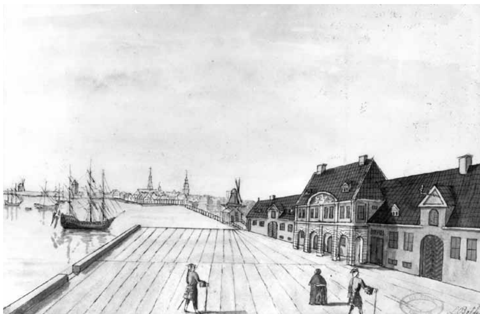
Fig. 5. Grafisk blad fra 1749 der viser generalbygmester J.C. Ernsts Toldkammerbygning fra 1733 med sandstensrelieffet (se fig.2), i den halvrunde frontispice. Bemærk at pladsen foran toldkamret var et plankegulv, der hvilede på nedrammede pæle. Senere blev området foran bygningen tørlagt og fyldt op. I 1894 blev Ernsts toldkammerbygning nedrevet og Frilagerkompleksets Havnesfløj opført næsten samme sted, ligesom sandstensrelieffet blev flyttet til Frilagerbygningen (se fig. 7 og 9). I dag ligger rederiets A.P. Møllers kontorbygning på stedet (se fig. 4). (Ill.: Københavns Toldbod 1749).
