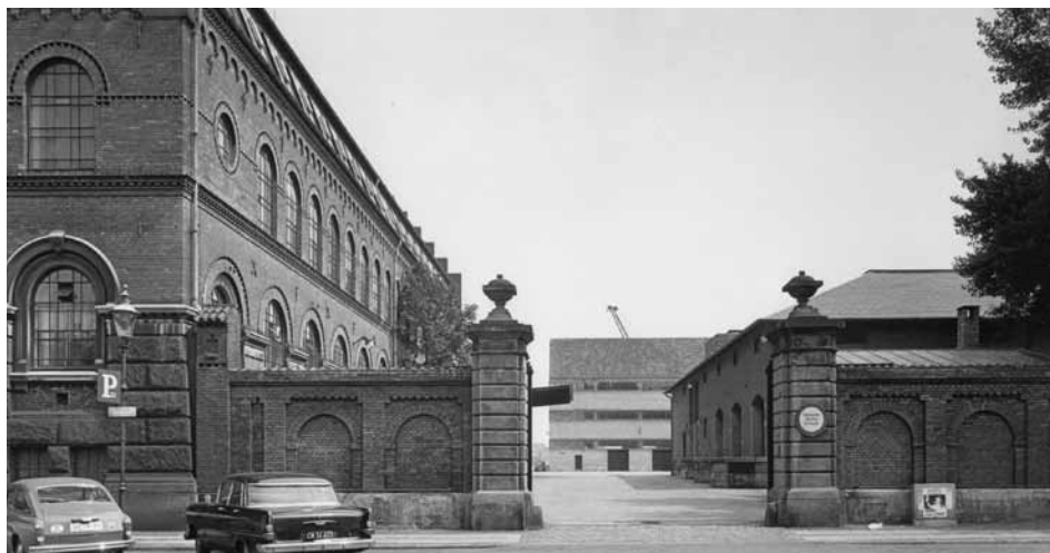
Fig. 8. Amaliegadefløjen af Frilagerkomplekset i 1971. Midt i billedet ses de to søjler, der nu flankerer indkørslen til Vestindisk Pakhus (se fig. 2), og bagerst ses Kielerpakhuset. Bemærk de mange bygningsdetaljer på Frilagerbygningen og den markante mur, der omgav Søndre Toldbod. (fotograf: Strüwing 1971. Told- og Skattemuseet).
