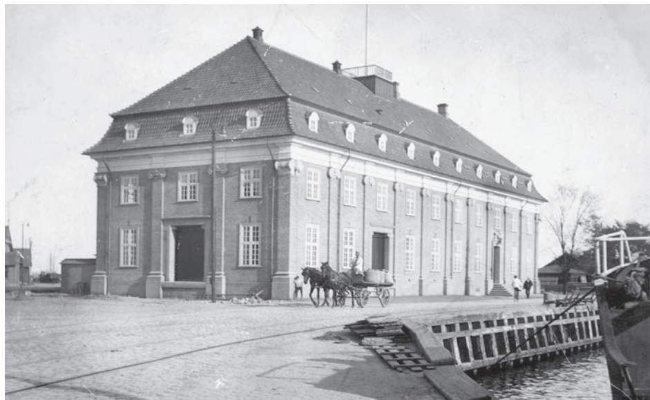
Horsens Toldkammer med vestfacaden ud mod Gamle Havn, fotograferet, da det var helt nyt. I vestfacaden pakhusets læsseport og hovedindgang, i nordgavlen pakhusets anden læsseport. Foto fra 1913 i Told Skat Museet.
