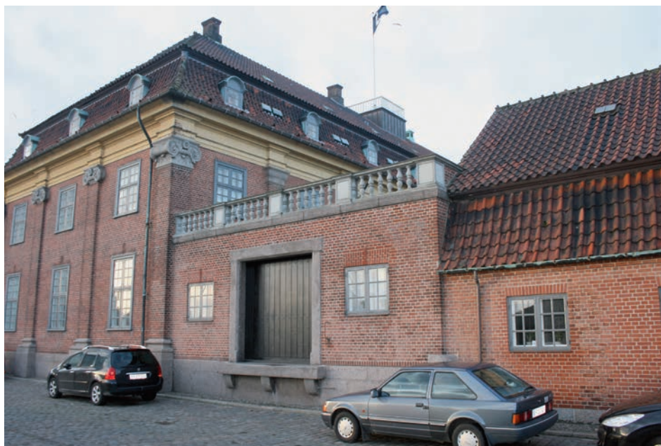
Toldkammerbygningens sydgavl og udleveringsrummets sydmur med læseport. Fundament og læseportens gulv og ramme er udført i granit. Foto Ole Degn 2012.
