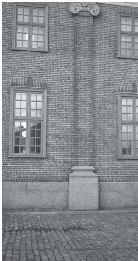
Et udsnit af sydgavlen med pilaster med base og jonisk kapital og vinduer med fint profilerede sandstensrammer og smårudede vinduer. Foto Ole Degn 2012.
